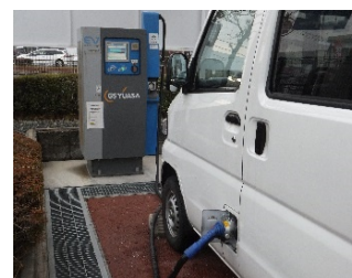
EV急速充電器
